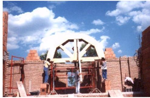
Par contre, de par sa forme, un cul de four nécessite, pour sa construction, un appui. En préalable, on construit donc un arc sur lequel les demi-rangs vont s'arrêter et bloquer le temps de la construction.
