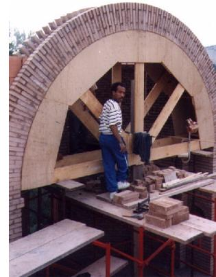
Au Thoronnet, cet arc a un profil en U d'une largeur correspondant à deux briques posées dans leur longueur.
