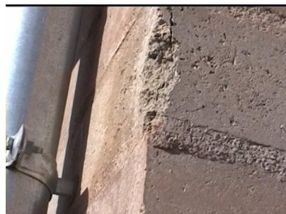
**Avec les terres de la région d'Embrun, il faut au moins stabiliser à 10 % de ciment CPA pour obtenir une résistance au gel des briques réalisées avec une presse manuelle.**
