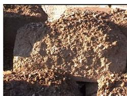
Sur un abri-bus construit à Embrun, la surface des briques exposées aux intempéries montre un aspect «piqueté» :
