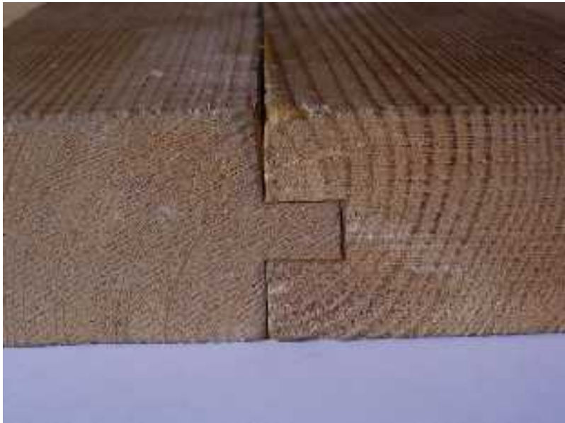
Assemblage par rainure -languette.
