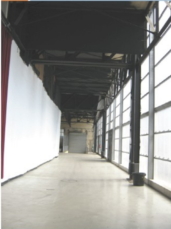
< Façade Sud de l'intérieur
