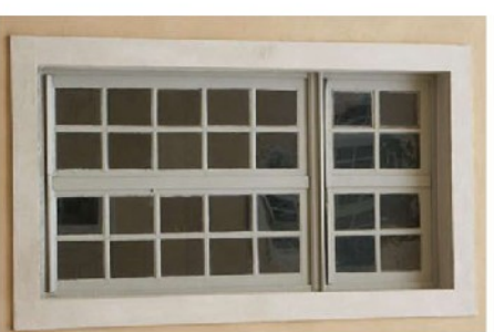
Fenêtre XVIIIe avec sa menuiserie d'origine (maison des châteaux)
