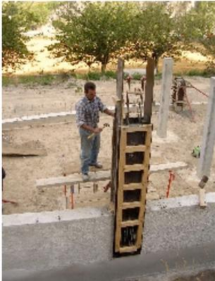
Les fondations et les naissances de poteaux sont en béton armé, ils devront supporter une ossature bois en mélèze massif de deux étages et demi.
