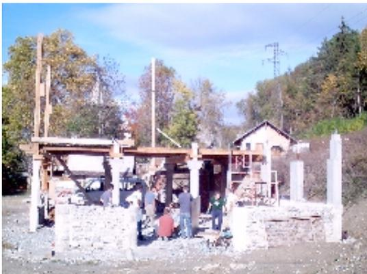
Le plancher du premier étage est en cours de préparation, solivage et coffrage pour la future dalle bois et béton collaborant.
