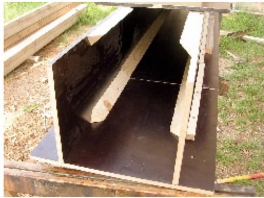
Préparation des coffrages pour les poteaux béton du rez de chaussée.
