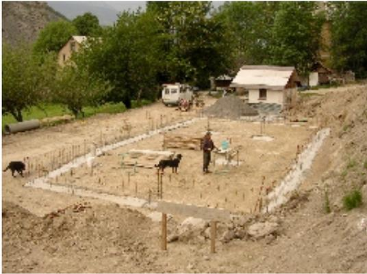
Préparation des fondations en béton armé.
