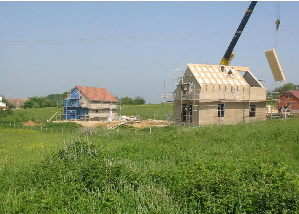
**Construction dans un contexte expérimental de deux maisons ossature bois à remplissage ‘bottes de paille’ et ‘béton de chanvre’.**
